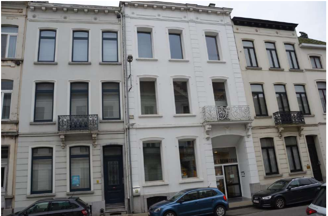
Figuur 22: Foto Stationsstraat 49, 51 en 53, Ninove © Erik Neven
