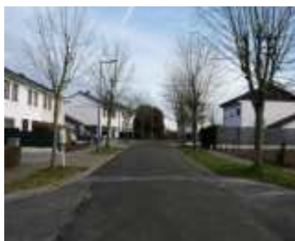
Straatprofiel in de Ter Duystlaan
