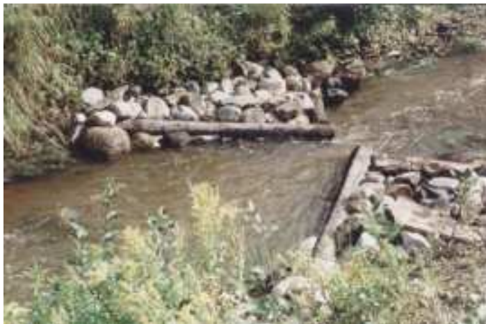
Figuur 27 Stroomdeflector met stenen en hout (bron: www.afterwildfire.org )
