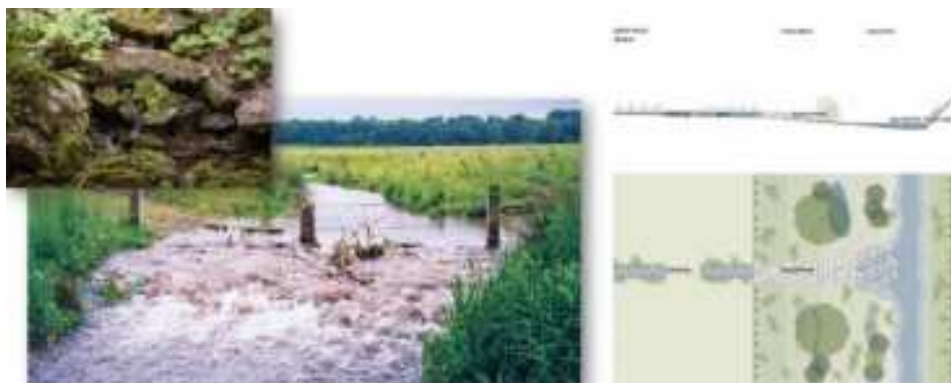
Figuur 23 Waterretentie door dropweir (bron: www.vmm.be )
