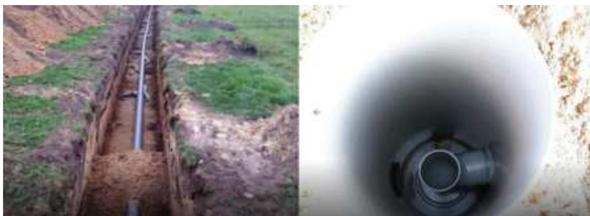
Figuur 18 Voorbeeld peilgestuurde drainage (bron: www.boerennatuur.be )
