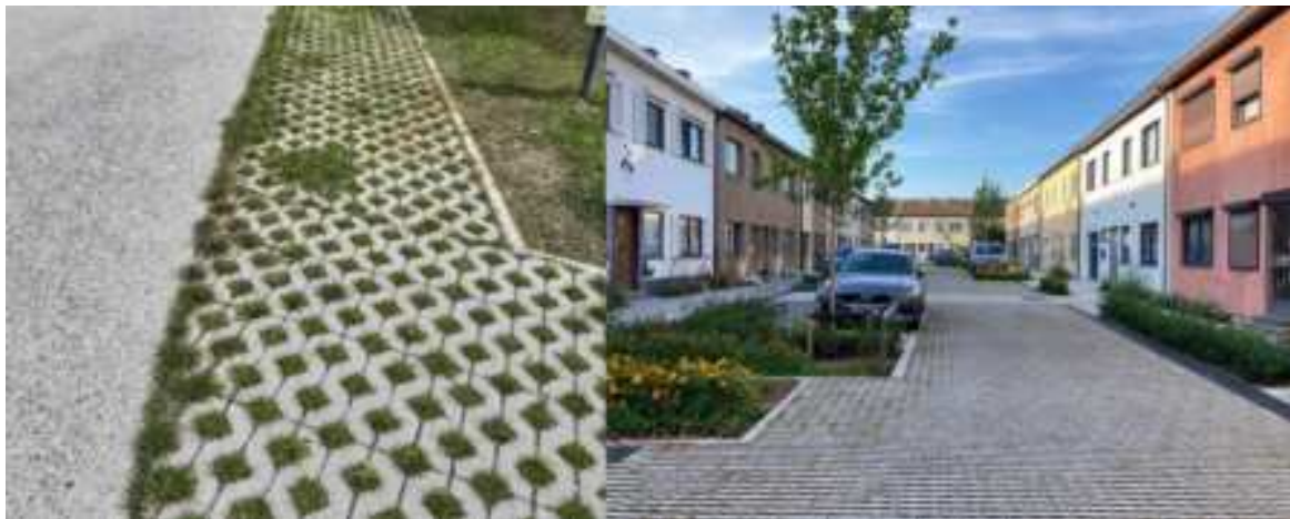
Figuur 31: Vlnr: (1) versmald voet-fietspad met uitwijkmogelijkheid over waterdoorlatende verharding (Overijse - © Aquafin); (2) tuinstraat met zowel rijweg als parkeervakken aangelegd in halfverharding (Aziëlaan, Wilrijk).
