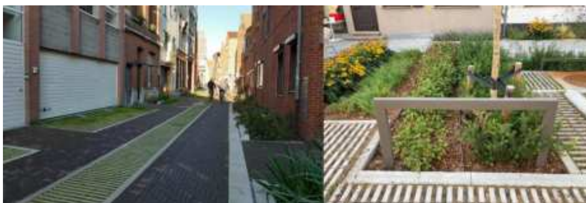
Figuur 33. Vlnr: (1) Ontharding met boven- en ondergrondse infiltratie in centrum Antwerpen (tuinstraat Lange Ridderstraat, Antwerpen) (© Aquafin); (2) Infiltrerende plantvakken in Aziëlaan (tuinstraat Wilrijk).
