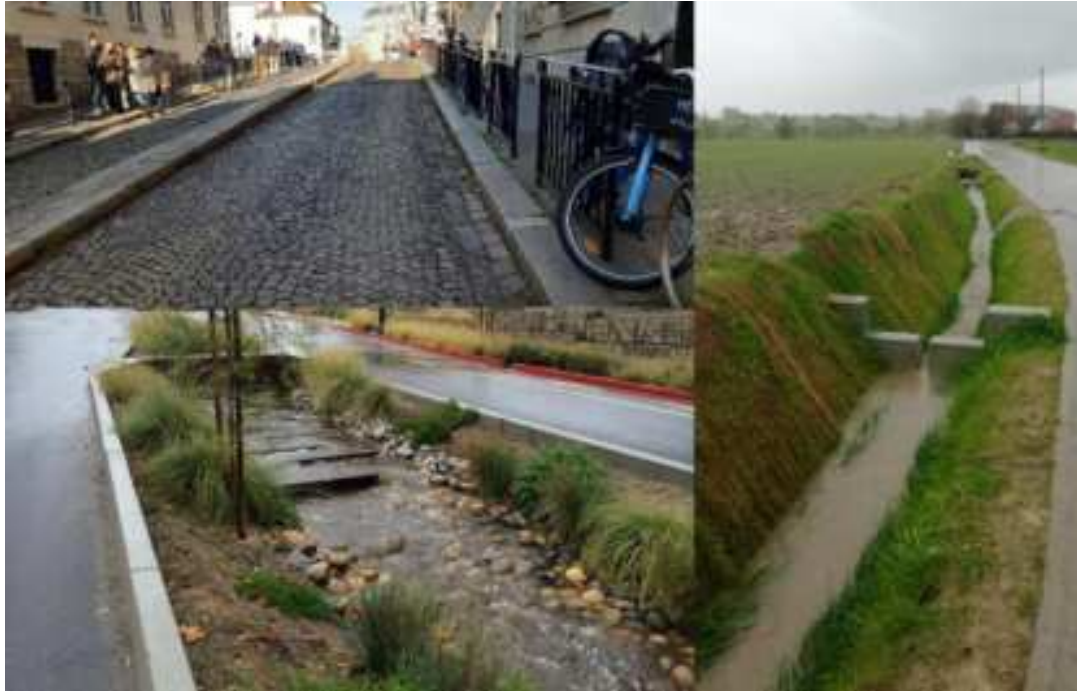
Figuur 37. Vlnr en vbno: (1) verhoogde borduren van voetpaden in Parijs (© Aquafin); (2) doorvoer waterloop in groenberm straat (© svrdesign.com) en (3) gracht met bufferschotten (© Kruisem).
