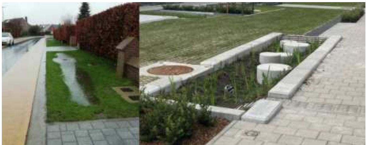
Figuur 35. Vlnr: (1) Infiltratiekom langs de straat (© Kruisem); (2) Bufferend plantvak (Aziëlaan Wilrijk, tuinstraat).
