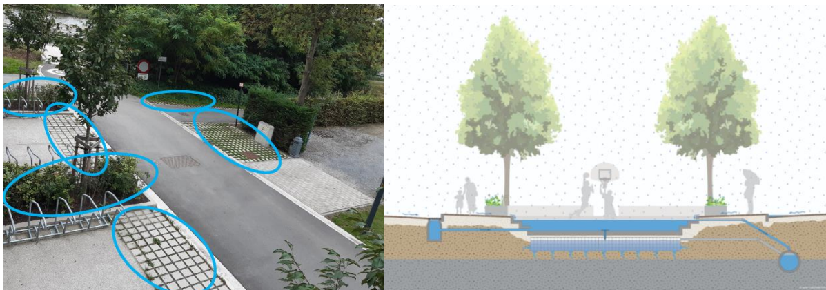
Links: voorbeeld van aanleg van delen van het wegprofiel in waterpasserende verharding (blauwe omcirkeling) in Gent. Rechts: principe van een verdiept aangelegd waterplein waarbij waterberging gecombineerd wordt met een sportterrein, bron: blauwgroenvlaanderen.be
